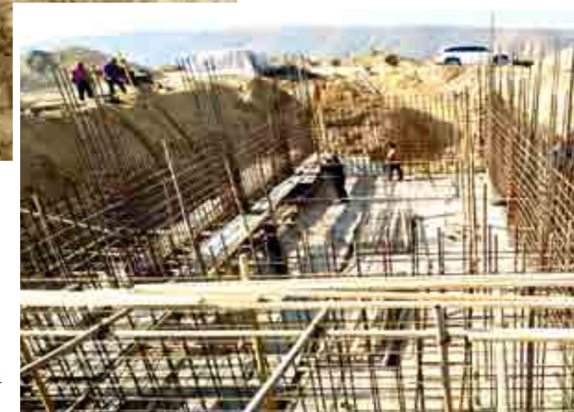
水利泵站建设
