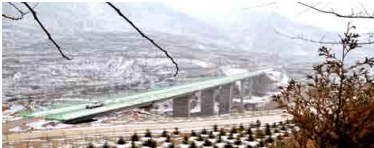
建设中的折红公路
