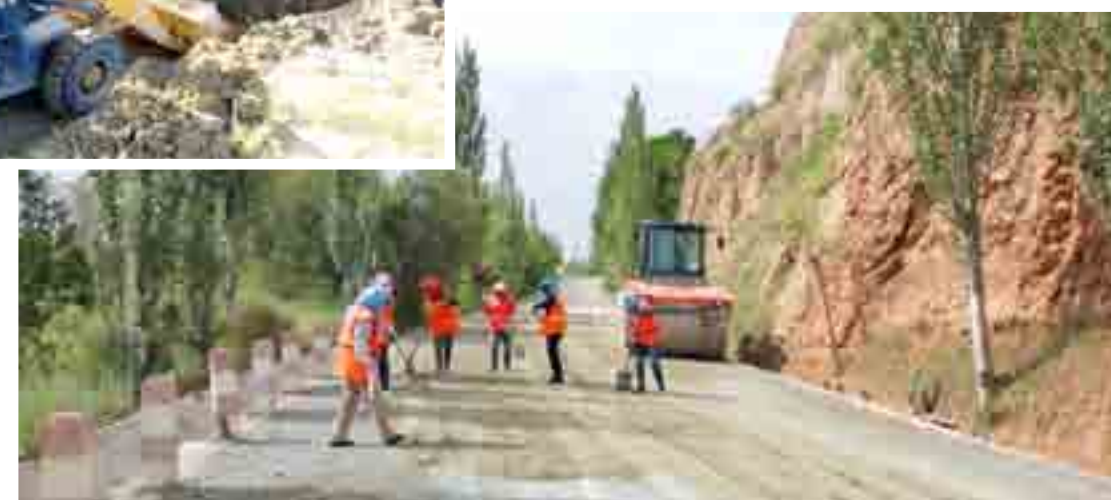
乡村道路建设
