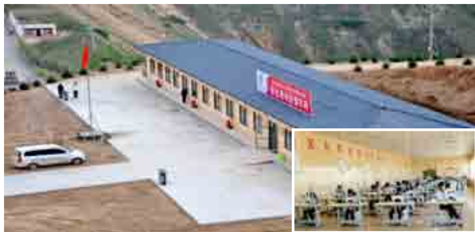
拱北湾村扶贫车间
