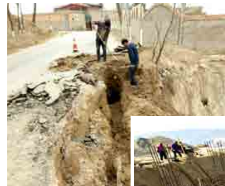
农村饮水管网维修
