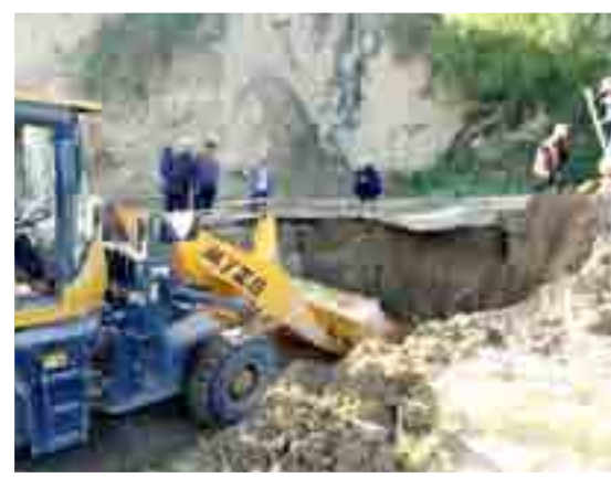
水毁道路维修
