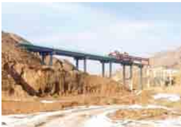
建设中的折红公路
