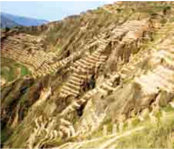
水土保持综合治理工程
